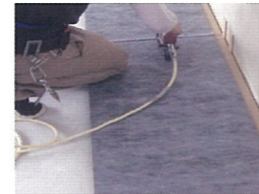
③ マットの固定 タッカー止め(目安 200mmピッチ)
