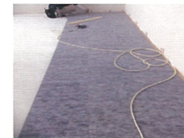
⑧ 施工 レンガ張り
