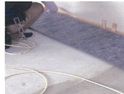
② 防音材の敷き込み 壁面より3~5mm隙間を取る
