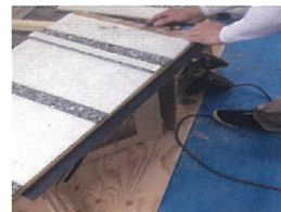
⑤ ウレタン緩衝脚の取付 吸音材を剥がす
