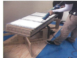
① ウレタン緩衝脚に接着材塗布 1液湿気硬化型ウレタン系接着材
